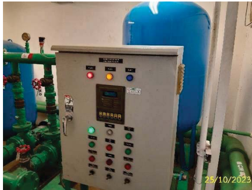
เครื่องสูบน้ำเพิ่มแรงดัน
