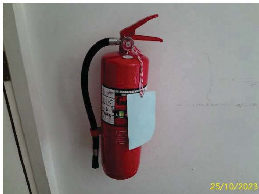
ถังดับเพลิงแบบผงเคมี
